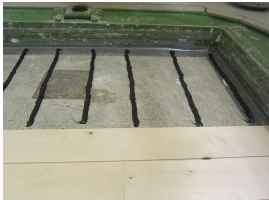
Kuva 1: Lautojen kiinnitys alustaan
